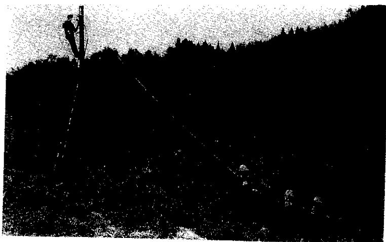
圖 3-44 空曠地帶，可直接佈放補助吊線
