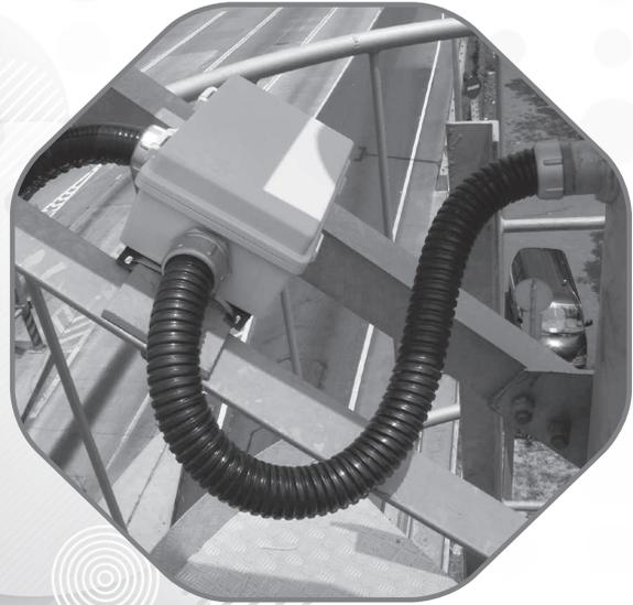
附圖-6 管路較易進水的接線箱配置
