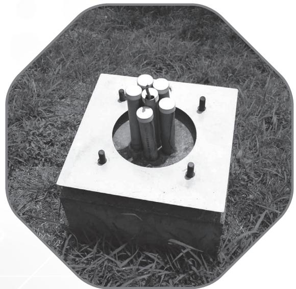
附圖-1 良好的管道出線口處理
